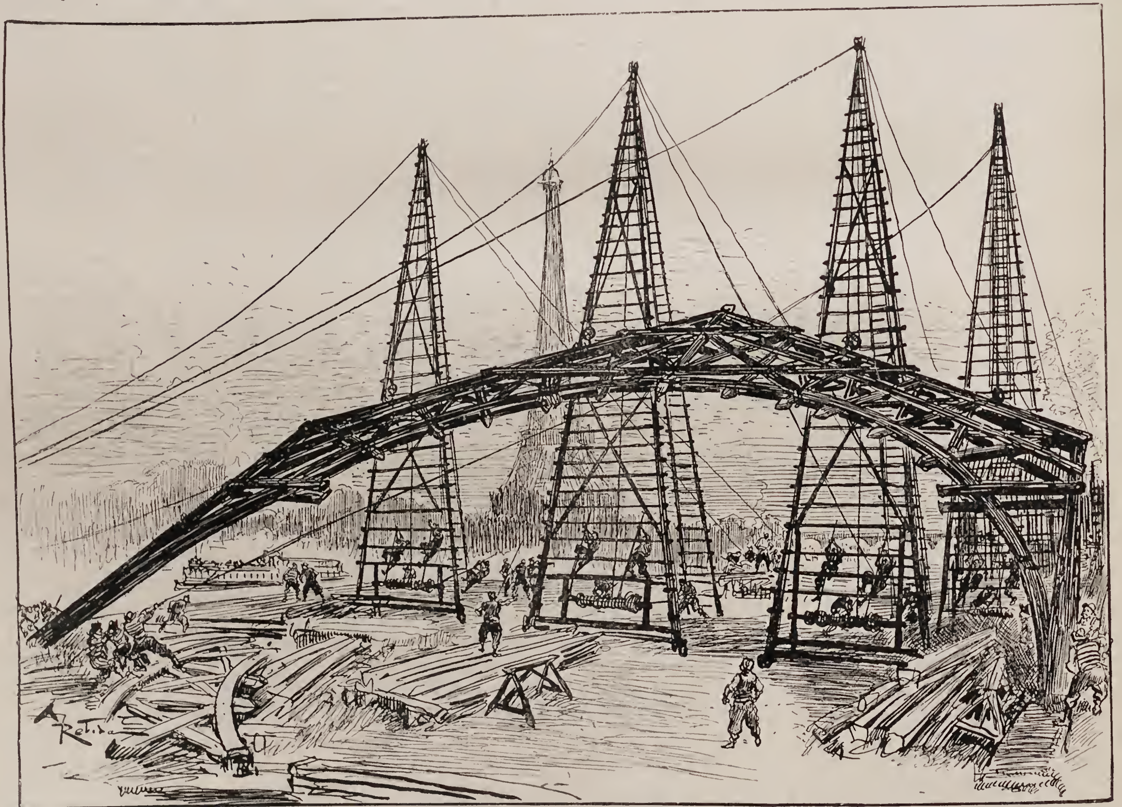
LE VIEUX PARIS A L'EXPOSITION. — Levage d'une ferme en bois montée, de vingt-cinq mètres de portée.
